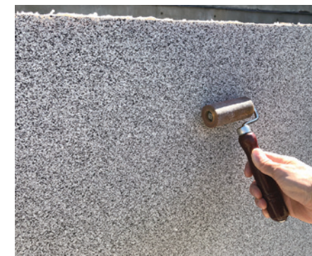
⑬ 最後に残っている空気がないか確認する 為、ローラーでしごきます。
