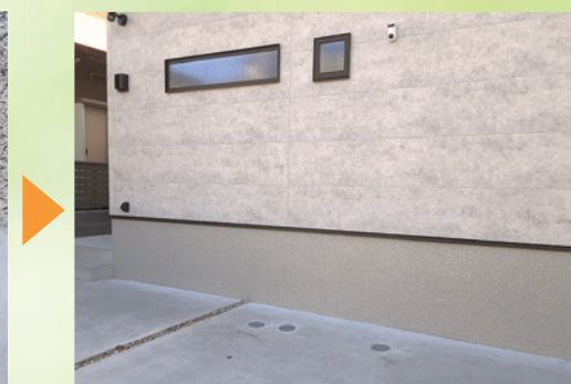
土間打ち後貼り付けた場合は、端部にコーキングを施して下さい。
