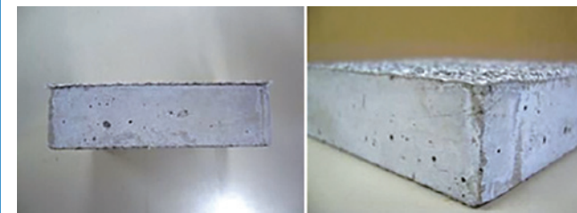
写真1 モルタル_耐候性試験1,000h 曝露後
