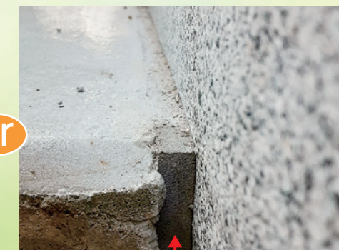
シート貼り付け後に土間打ちする場合は必ず縁を切って打設して下さい。
