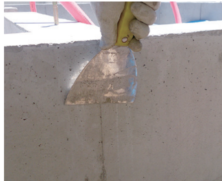
② 型枠段差はスクレーパーやグラインダーで平滑に削るなど、モルタルで平滑に均します。
