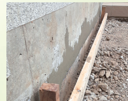
シート貼り付け後に土間打ちする場合は必ず縁を切って打設して下さい。
