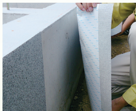
⑧ ジョイント部は端の離形紙のみを剥がして貼ります。
