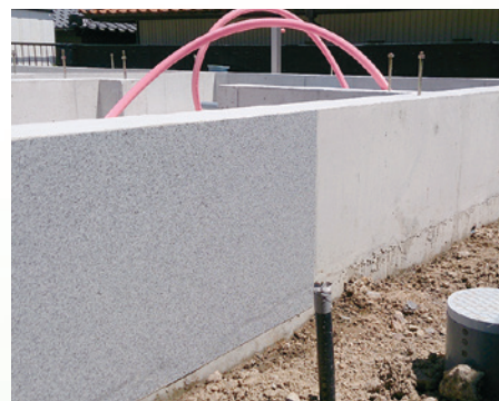
⑦ 任意の始点から、基礎天端に合わせてシートを貼っていきます。
