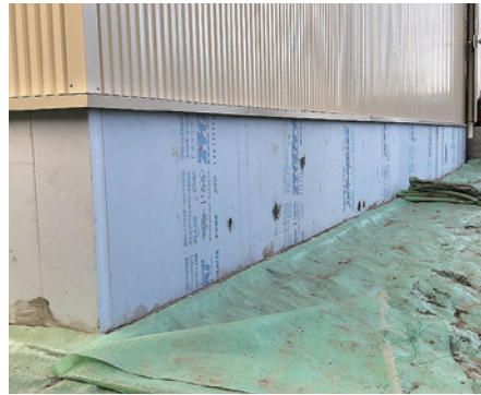
⑤ 断熱材も同様に段差・穴補修
