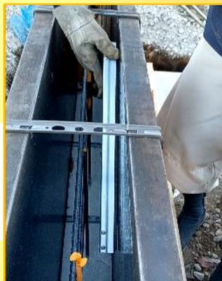
パネル組付け後でも鉄筋を汚さずに塗れます。
