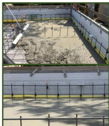
打設→打設完了
