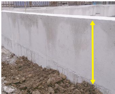
① 枠をばらします。 表面の段差、不陸を確認します。
