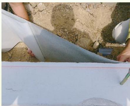
⑩ 離形紙が破れないよう水平にめくりま す。別売で一人施工可能な後貼貼付補助 具もございます。(P1を参照)
