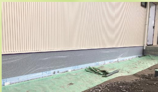
④養生を下げ、掘った下端を埋戻し、作業完了となります。
