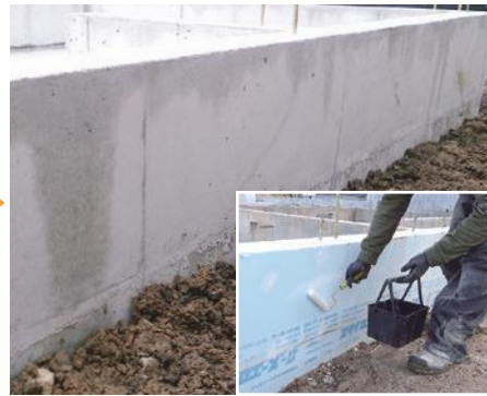
⑥ 水性シーラー塗布後、完全に乾いたことを確認してください。
