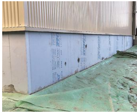
⑤ 断熱材も同様に段差・穴補修
