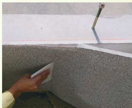
⑪ 端を貼り合わせたら、基礎側面に沿っ て、ヘラを使ってさらに離形紙を剥がし ていきます。
