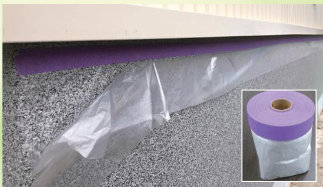
③塗料が乾いたらプレミアムマスキータープで養生をします。
