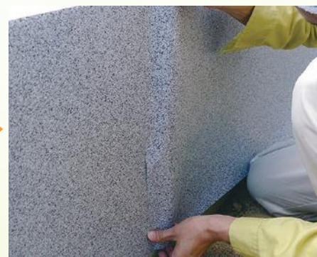
⑨ 継ぎ目に合わせて貼ってください。 下地が断熱材の場合は、重ねて貼ってください。
