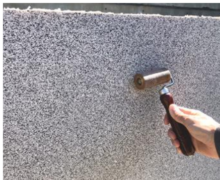
⑬最後に残っている空气がないか確認する為、ローラーでしごきます。
